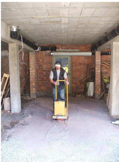
S. Zimmermann beim Planieren der neuen Garage
